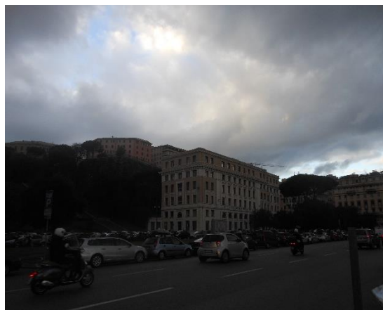
Figura 1.1 - Vista della facciata esposta a Nord
