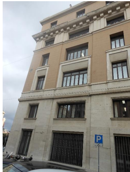
Figura 4.1 - Particolare della porzione di involucro – pareti verticali opache
