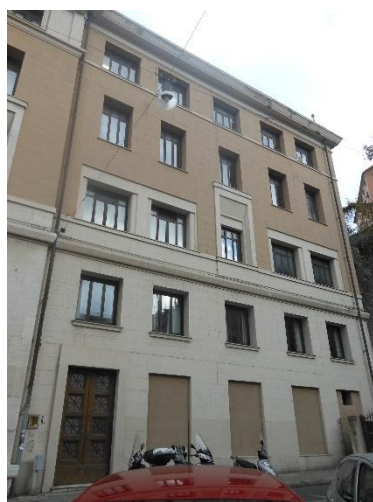
Figura 8.1 – Particolare della facciata oggetto di intervento
