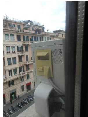
Figura 4.13 - Particolare di un sistema monosplit
