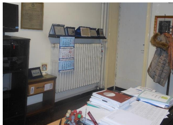
Figura 4.5 - Particolare dei radiatori
