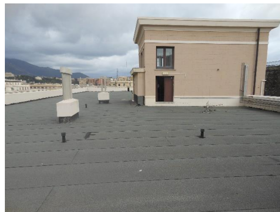
Figura 4.2 - Particolare della copertura
